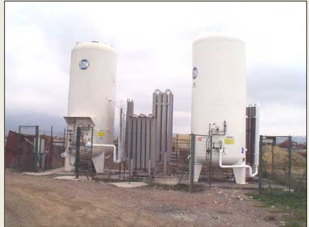
Serbatoi di ossigeno liquido
